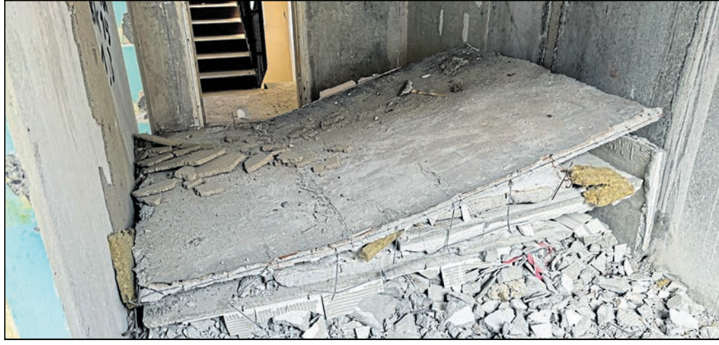
Wo hier die Wände umgestoßen auf dem Boden liegen, hat sich zuvor das Badezimmer in einer Wohnung im Häuserblock an der Kurt-Pchalek-Straße 22 bis 26 in Bautzen befunden. Foto: ksl
