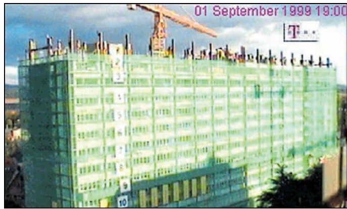
Im August 1999 installierte der Verlag des Oberlausitzer Kurier die wohl erste öffentliche Webcam in Bautzen und nahm den Abriss des Hochhauses am Kornmarkt auf. Fotos: Screenshots
