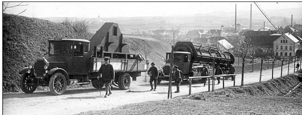
Transport der neuen Siebanlage zum Steinbruch „Alter Hutberg“ in der Bernstädter Straße in Ostritz um 1928. Sammlung: Tilo Böhmer
