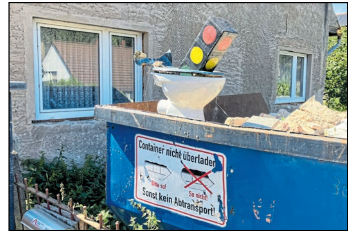
Ein Nieder-Neundorfer Einwohner lässt die Passierenden mit dieser „Ampelinstallation“ in einem Bauschutzcontainer schon lange wissen, was er von der Ampel hält. Foto: Till Scholtz-Knobloch
